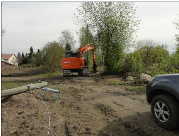
Miemala: Pylväs poistetaan koneella sahaamalla se poikki ja nostamalla. Noston jäljet maassa.
