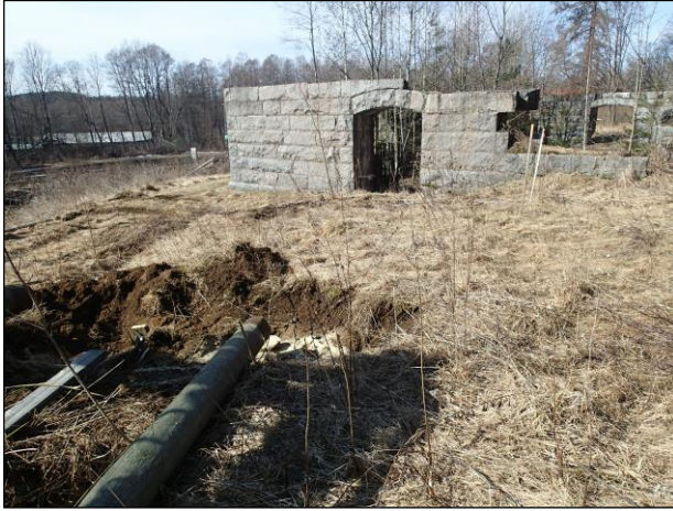
Vasemmalla: poistetaan ja (oikealla vielä pystyssä) sähköpylvästä Hämeenlinnan Kirkonkulmalla kaasuasemalta luoteeseen. Pylväiden tyvi kaivettiin esiin, minkä jälkeen puutolpat katkaistiin moottorisahalla.
