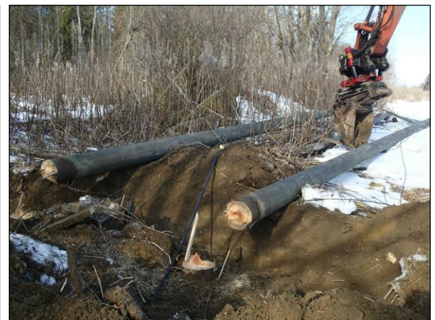
Vasemmalla: arkeologisessa valvonnassa poistetaan sähköpylvästä Hämeenlinnan Kirkonkulmalla Vanajan vanhan pappilan päärakennuksen pohjoispuolella. Harusvaijerit irrotettiin harusvartaista, jotka kaivettiin osin esiin ja katkaistiin. Niiden tyviosa ja haruslaatat jäivät paikoilleen. Kuva pohjoiseen. Oikealla: Pylväiden tyvi kaivettiin esiin, minkä jälkeen puutolpat katkaistiin moottorisahalla..
