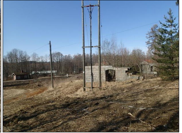
Vasemmalla: poistetaan ja (oikealla vielä pystyssä) sähköpylvästä Hämeenlinnan Kirkonkulmalla kaasuasemalta luoteeseen. Pylväiden tyvi kaivettiin esiin, minkä jälkeen puutolpat katkaistiin moottorisahalla.
