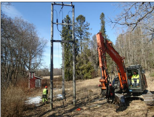
Vasemmalla: arkeologisessa valvonnassa poistetaan sähköpylvästä Hämeenlinnan Kirkonkulmalla Vanajan vanhan pappilan päärakennuksen pohjoispuolella. Harusvaijerit irrotettiin harusvartaista, jotka kaivettiin osin esiin ja katkaistiin. Niiden tyviosa ja haruslaatat jäivät paikoilleen. Kuva pohjoiseen. Oikealla: Pylväiden tyvi kaivettiin esiin, minkä jälkeen puutolpat katkaistiin moottorisahalla..
