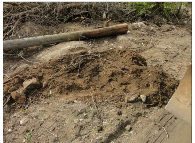
Miemala: Pylväs poistetaan koneella sahaamalla se poikki ja nostamalla. Noston jäljet maassa.
